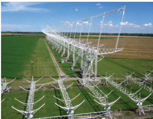
FIG. 7. Il Radiotelescopio Croce del Nord a Medicina (Bologna). In primo piano parte del ramo Nord-Sud e in profondità il ramo Est-Ovest. (Crediti: INAF-IRA)
