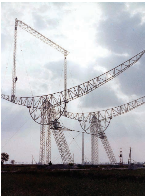
FIG. 6. Le prime centine della Croce del Nord erette a Medicina ai primi del 1963. Si noti il colore bianco senza le striature rosse fatte dipingere da Antonioni per il film. (Crediti: INAF-IRA)
