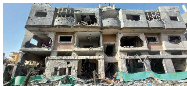
FIG. 2. La casa di Maysoon dopo i bombardamenti.
